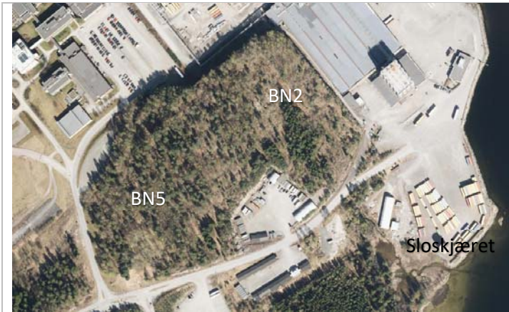
Figur 5-3 Kolle innenfor planområdet som sprengt vekk
