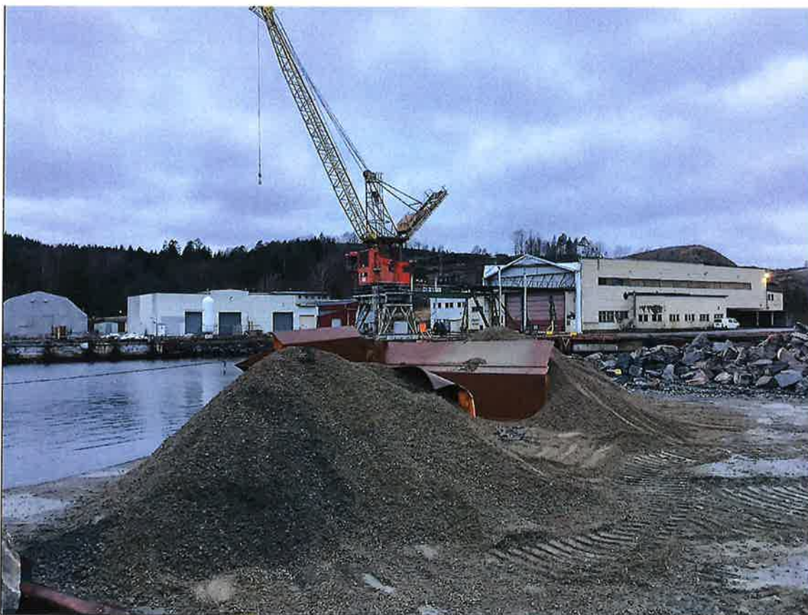
Figur 4 Bilde av lastelomme kledd inn i masse som støyreduserende tiltak. Kilde Hæhre Entreprenør AS
