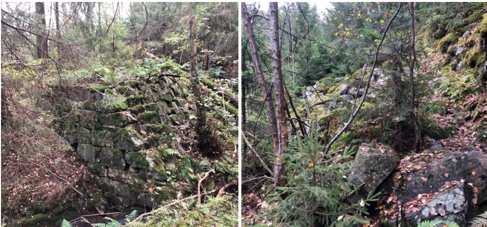
Figur 7-44. Brofundament for togbanetrase for malmtransport (Id 129892). Skiltet lokalitet. Til høyre typisk dagbrudd/skjerp der bruddmasser ligger i nedkant.
