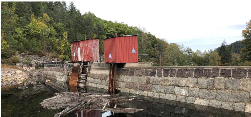
Figur 7-37. Kongens dam fra 1903 Kongens dam er en murdam ved utløpet av Hellestveitvatnet i Herreelva (Statlig listeført kulturminne/NVEs utvalgte kulturminner).
